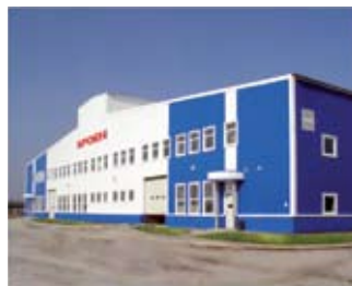
Производственный комплекс BROEN в Коломне
